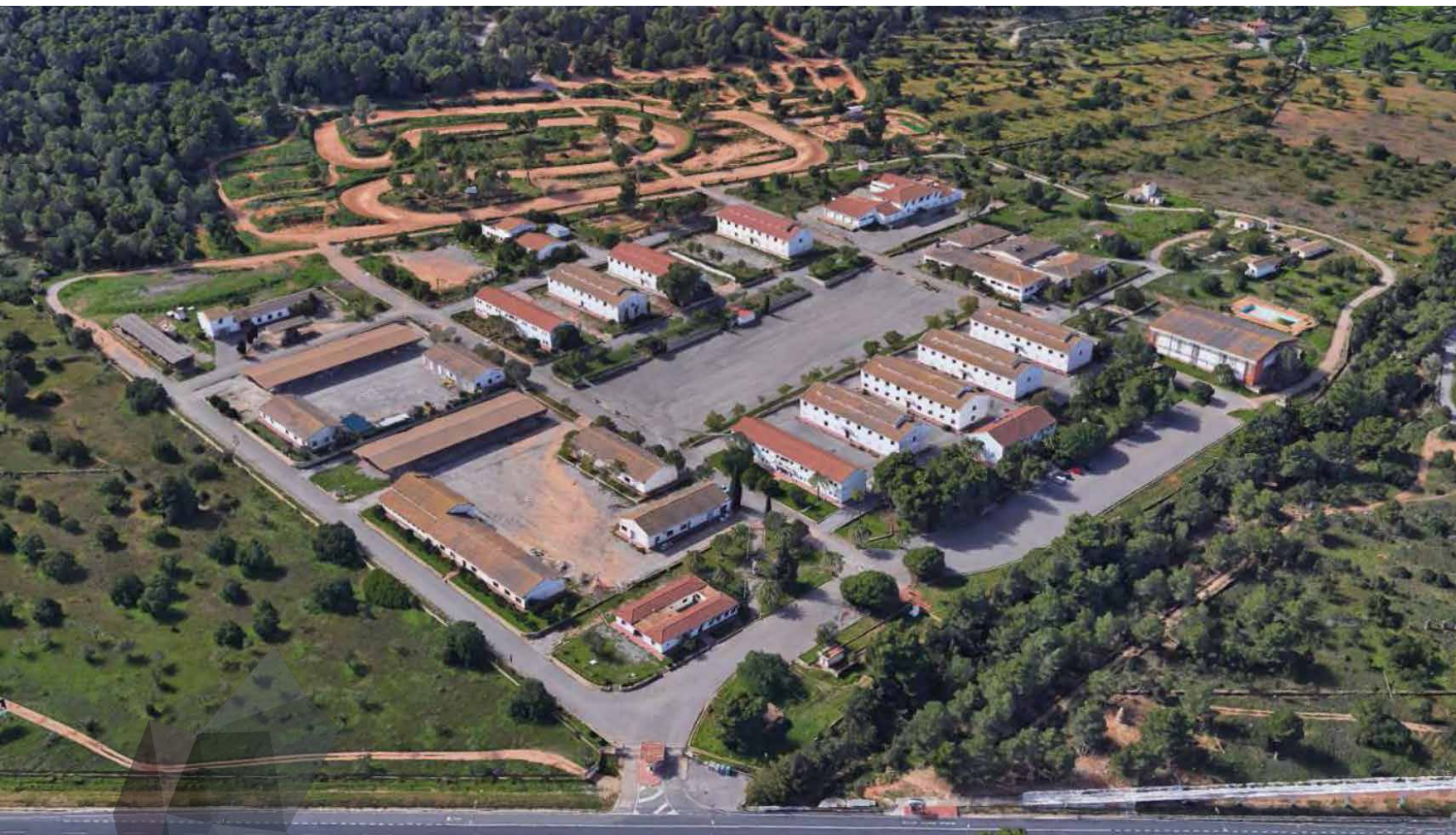
Vista aérea del complejo de Sa Coma
